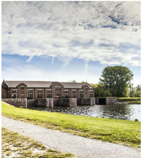
Station de pompage à vapeur de D.F. Wouda © Land Id
